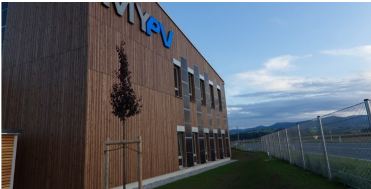
MyPV erzeugt mit PV am Dach und an den Wänden an den meisten Tagen mehr Energie als benötigt. Foto: Herbert Starmühler
