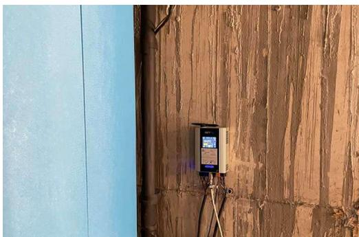
Zwei Photovoltaik-Leistungsteller von my-PV versorgen die Hotelgäste auf Santiago mit genügend Warmwasser aus dem Überschussstrom aus der hoteleigenen Photovoltaikanlage.
