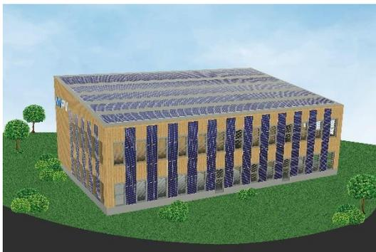
Solarelektrisches Firmengebäude: Auf dem Dach und an der Fassade werden rund 300 Solarmodule installiert.
